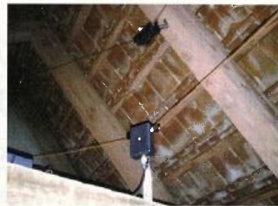
Obr. 20. Montáž balunu a zatěžovacího rezistoru na trámy
